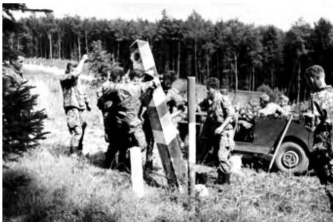
Abbildung 26: Einbau von Grenzsäulen.
